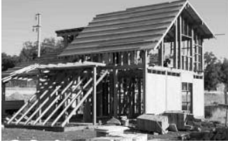
Resim 7 Güneş Evi'nin Ahşap Strüktürü
