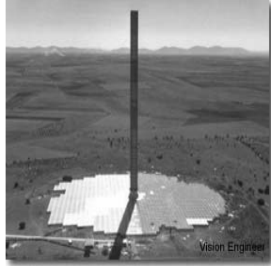
Şekil. 6 İspanya Manzanares deki prototip güneş bacası[5]
