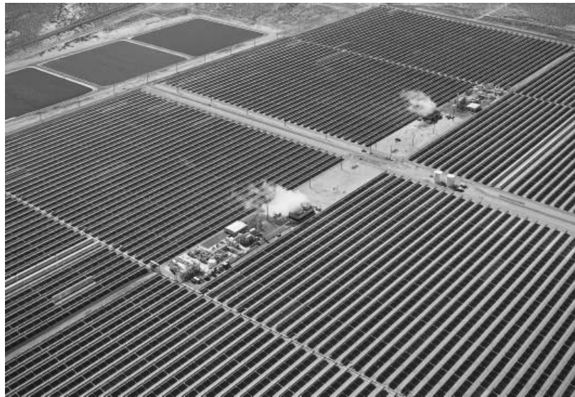
Şekil 2. AndaSol Güneş Enerjisi Elektrik Üretim Tesisi [1]
