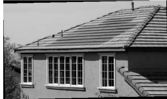
Şekil 2. Yapıda çatı kiremidine entegre edilmiş panel uygulaması (Anonim, 2008a).
