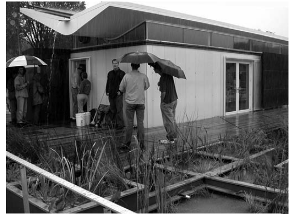
Şekil 10. Virginia Tech Güneş evinin görünüşü (Dunay vd., 2006).
