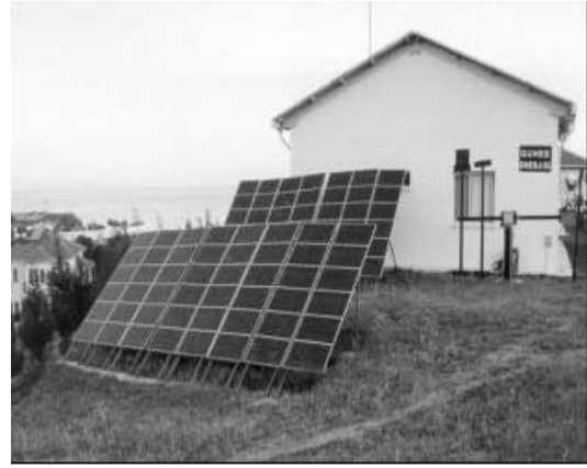
Şekil 6. 4.8 kW'lık şebeke bağlantılı güneş pili sistemi.
