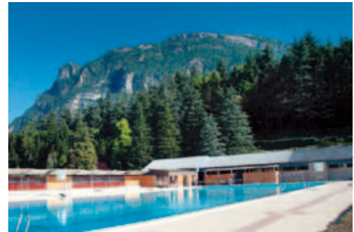
Le toit de la piscine de Montmélian (Savoie) est recouvert de panneaux solaires thermiques.
