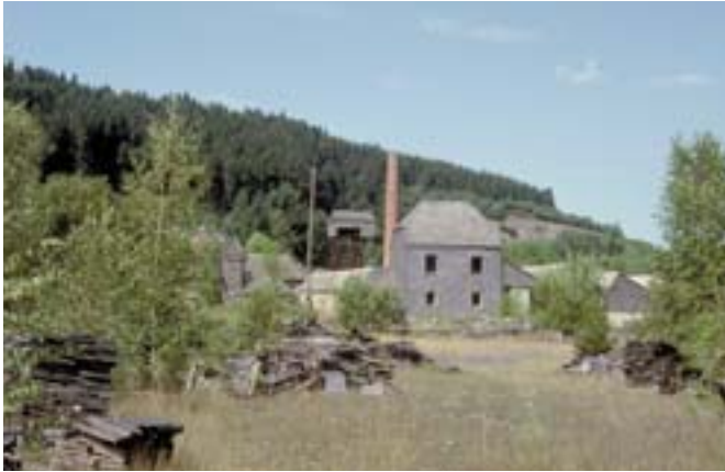
Photo 2.22. – Ancienne aire de stockage des produits finis de l'ardoisière Donner (G.12) à Martelange (2003): à l'arrêt de son activité, ce siège important commercialisait des ardoises de couverture mais aussi des produits plus épais, comme des dalles de parement (tas à l'avant-plan à gauche).
