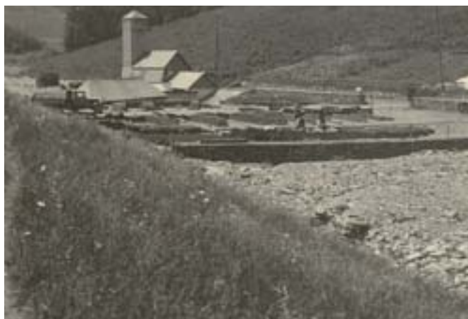
Photo 2.38. – Vue prise depuis le versant droit de la vallée : aire de stockage, ou chantier, entouré d'un mur, salle des machines et cabine électrique (vers 1943).
