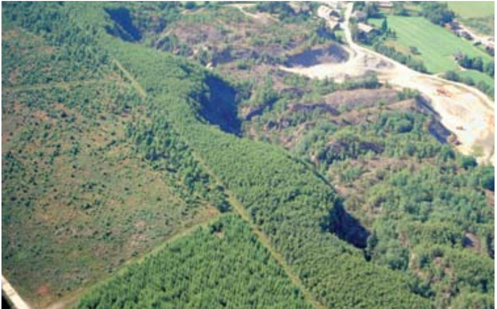
Photo 2.36. – Le Thier des Carrières à Vielsalm (H.2): série d'excavations pourvues d'accès aux ouvrages souterrains. Devant ces excavations où l'ardoise fut d'abord exploitée à ciel ouvert, les déchets pierreux résultant de l'extraction forment des accumulations volumineuses qui font encore l'objet de prélèvements, comme le montre cette photo prise en 1991.
