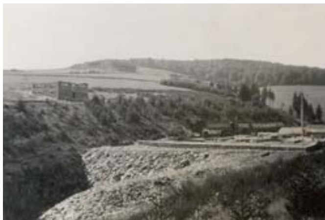
Photo 2.37. – Vue prise depuis le versant gauche de la vallée : accumulation des déchets de l'ardoisière, mur entourant l'aire de stockage des ardoises et maison du directeur alors en construction (vers 1937).
