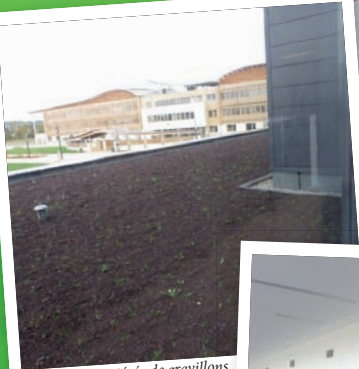
Une toiture protégée de gravillons et végétalisée partiellement
